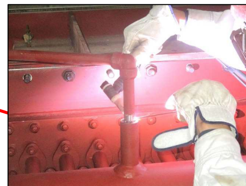
(エレメント取付)
