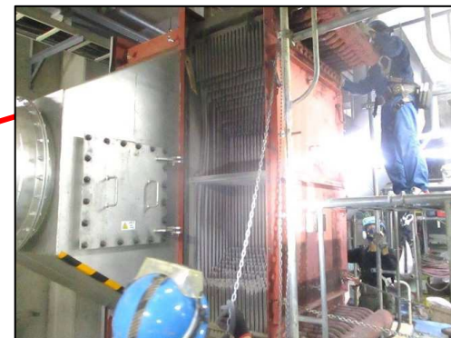
(エレメント撤去)
