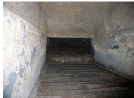
1号焼却炉耐火物(解体後)
