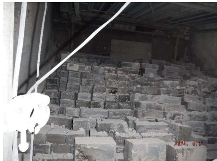
1号焼却炉耐熱レンガ(解体後)
