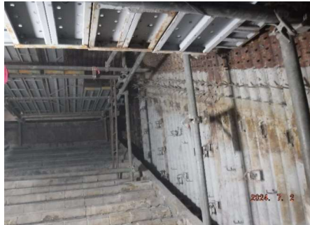
1号焼却炉耐熱レンガ(解体後)
